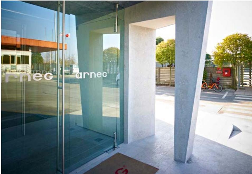
1500 mq di rivestimenti eseguiti in Bianco Avorio levigato e pavimentazione uffici realizzata con lastre a correre in Grigio Alpi levigate.
